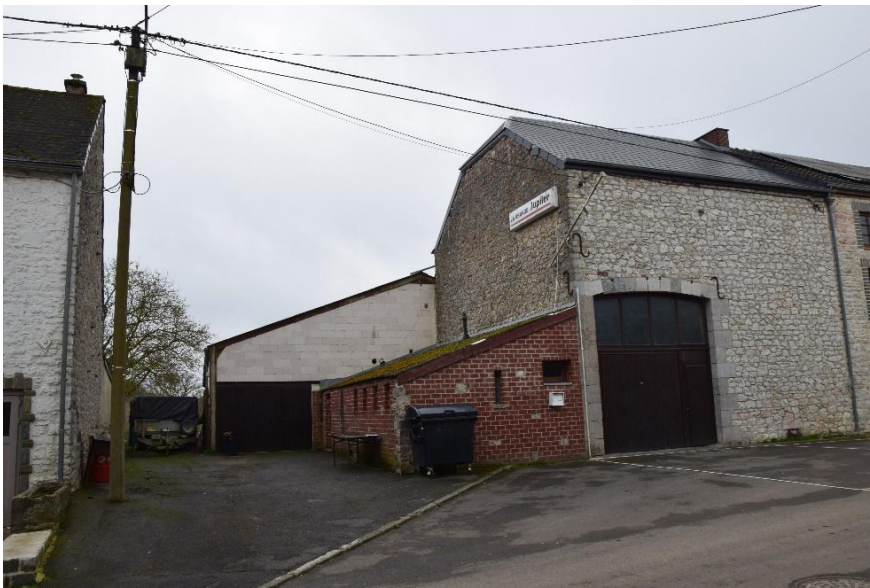
Vues extérieures de la salle
